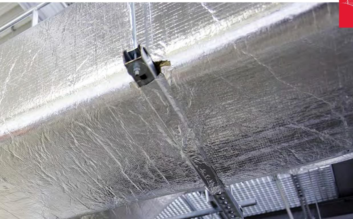
Die ROCKWOOL 133 ist eine nichtbrennbare, einseitig mit glasfaserverstärkter Aluminiumfolie kaschierte Steinwolle Lamellenmatte. Sie eignet sich insbesondere zur thermischen und akustischen Dämmung von Klima- und Lüftungskanälen.
